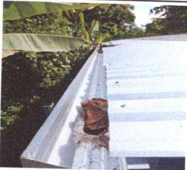
Foto 5: Se observa que se realizo la instalación de los canales para el agua.
