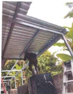
Foto 5: Se procede a la colocación de los canales para el agua.
