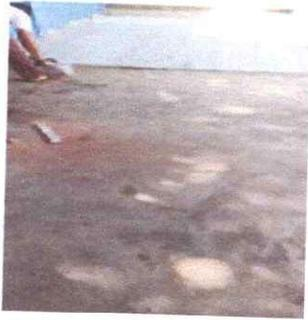
Foto 9: Se procede a realizar la sustitución del piso del corredor.
