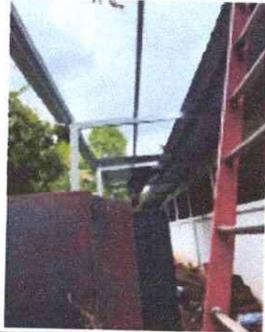
Foto 1: Se procede a realizar el cambio de la lámina en mal estado.
