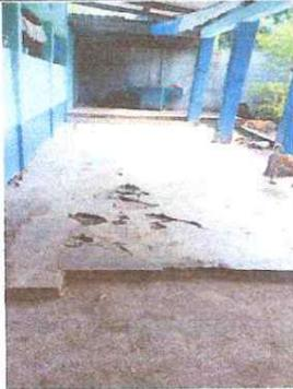
Foto 9: se observa el mal estado del piso lo cual requiere sustitución por piso cerámico.
