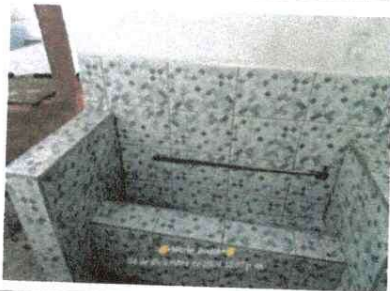
Foto 11: Se observa que se realizo la sustitución del mingitorio.
