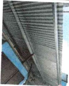
Foto 9: Se observa que se realizo el cambio de la estructura de soporte.
