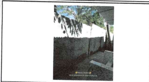
Foto 13: Se realizo el repello de muro.
