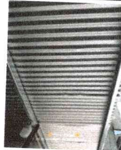
Foto 10: Se procede a realizar el cambio de la lámina.
