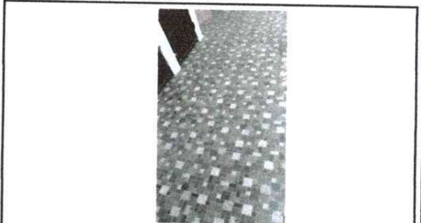
Foto 16: Se realizo la sustitucion por piso antideslizante.
