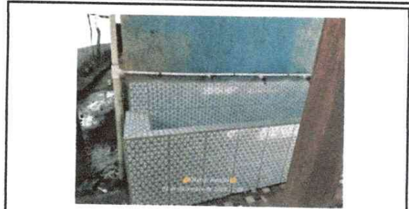
Foto 14: Se observa que se realizo la instalacion de la estacion de lavado.
