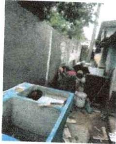
Foto 13: Se procede a repellar el muro.
