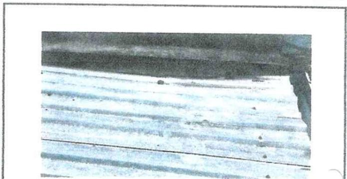
Foto 10: Se observa el mal estado de las laminas
