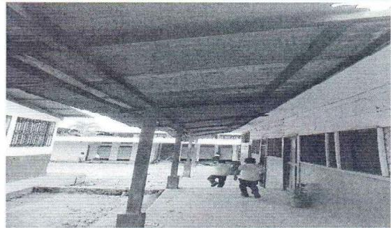
Foto 4: Se observa que la lamina del pasillo necesita ser cambiada
