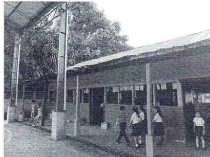
Foto 2: Se observa que las laminas estan en mal estado y necesitan sustituirse
