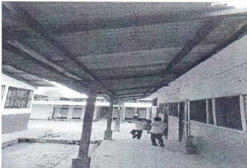
Foto 3: Se observa que la estructura de soporte de madera del pasillo esta muy deteriorada
