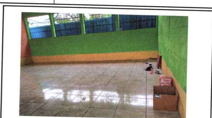
Foto 2: Se observa la instalación del piso cerámico.
