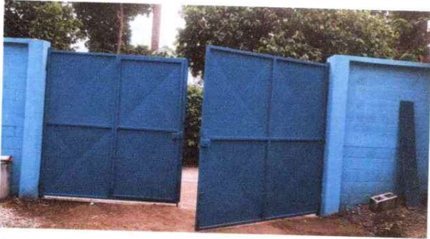
Foto 7: Se observa que le brindo el mantenimiento al porton de ingreso.
