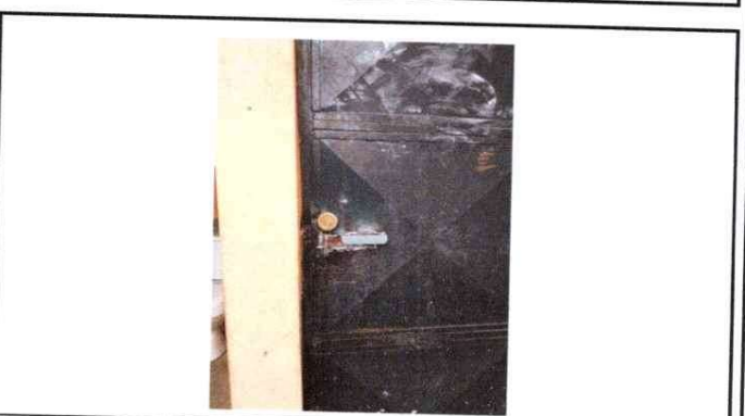
Foto 4: Se observa que se realizo la susitución de las chapas en las puertas.
