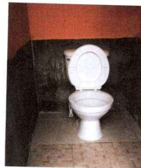
Foto 12: Se realizó la sustitución del sanitario.
