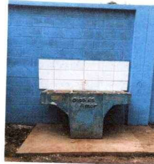
Foto 10: Se realizo la instalación de la tubería para el llenado y vaciado del agua.
