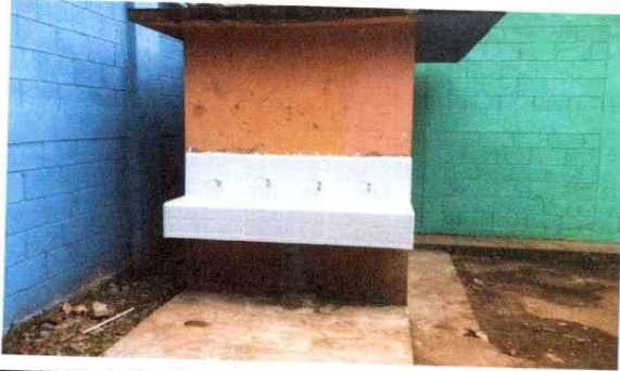
Foto 13: Se realizo la sustitución de la estación de lavado.
