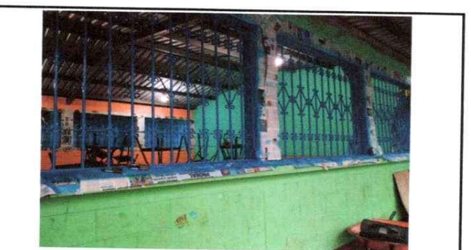
Foto 5: Se procede a darle mantenimiento a los balcones.
