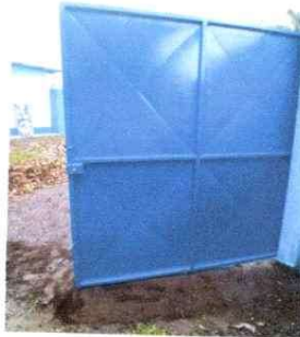
Foto 7: Se procede a brindarles el mantenimiento al porton de ingreso.
