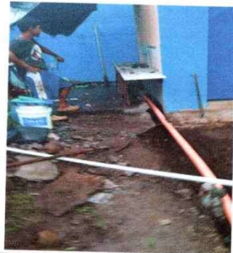
Foto 10: Se procede a realizar la instalacion de la tubería para el llenado y vaciado de agua.
