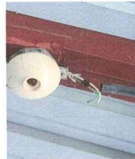
Foto 12: se observa que el sistema eléctrico no se encuentra en condiciones para uso.
