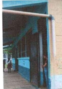
Foto 20: se observa que la tubería de bajada de agua ya no se encuentra en las condiciones para su funcionamiento.
