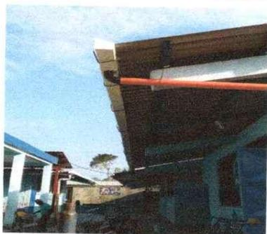
Foto 5: Se observa que se realizo la sustitución de los canales
