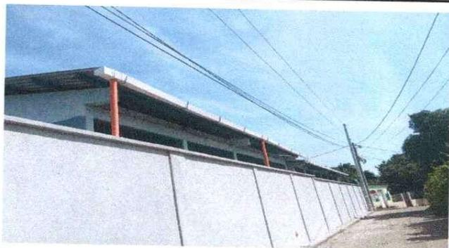
Foto 1: Se observa que se realizó el repello del muro.
