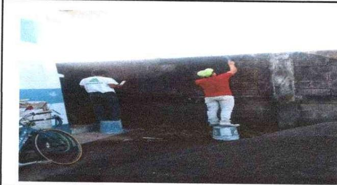
Foto 1: Se procede a realizar el repello del muro.
