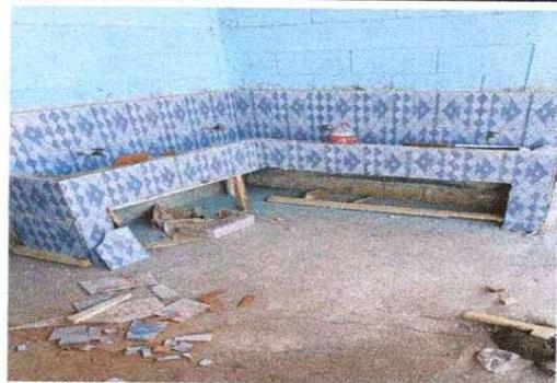
Foto 4: Se procede a instalar la estación de lavado
