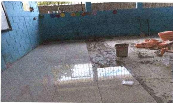
Foto 3: Se procede a sustituir el piso ceramico
