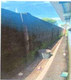
Foto 5: Se observa que los salones no poseen con canales para la caída de agua
