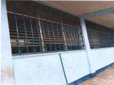
Foto 7: Se realizo la sustitución de los balcones
