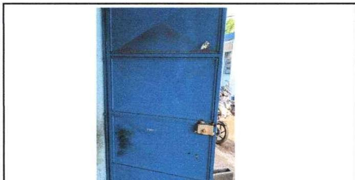
Foto 5: Se observa que se realizó la sustitución de las chapas
