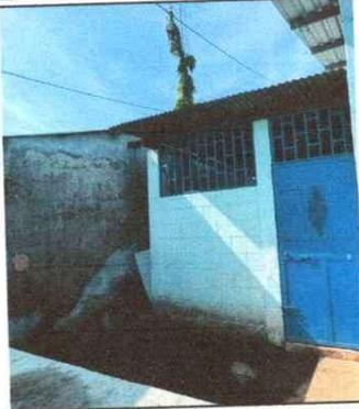
Foto 1: Se observa que la lámina de zinc, se encuentra en mal estado
