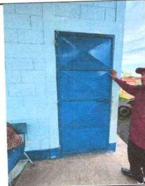
Foto 4: Se observan el mal estado de las puertas en distintas aulas
