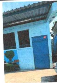
Foto 6: Se observa el mal estado de la puerta del aula
