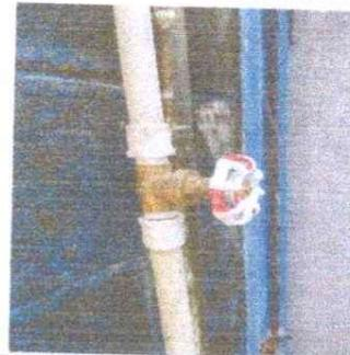
Foto 6: Se observa que se realizo el cambio de la llave de paso.
