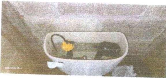
Foto 3: Se observa que se realizo el cambio de los accesorios.
