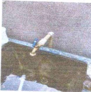
Foto 5: Se observa que se realizo el cambio del chorro.
