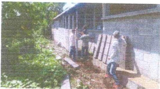
Foto 11: Se procede a instalar el muro perimetral prefabricado.
