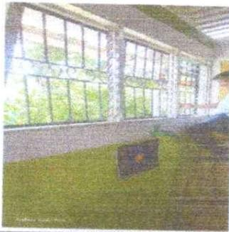
Foto 7: Se procede a realizar la colocación de las ventanas.
