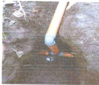
Foto 10: Se procede a realizar la sustitución de la tubería para las aguas negras.
