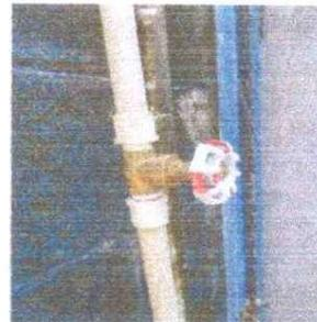
Foto 6: Se procede a realizar la sustitución de la llave de paso.
