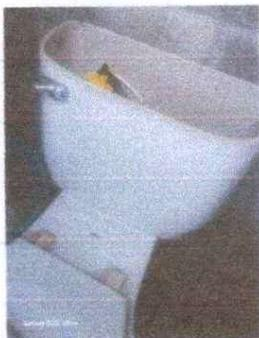
Foto 3: Se observa que el inodoro se encuentra en malas condiciones y requiere cambio completo.
