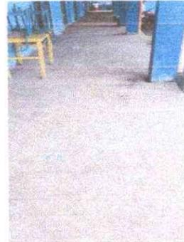
Foto 8: Se observa que el piso es demasiado liso y cuando llueve se torna resbaloso por lo que requiere ser cambiado por piso de granito
