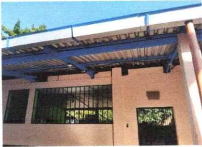
Foto 7: Se realizo la sustitución de estructura de soporte.
