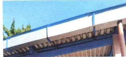
Foto 8: Se realizo la sustitución del canal para la bajada de agua
