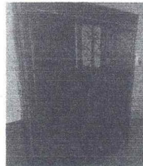
Foto 4: Se observa las puertas del módulo de aulas en mal estado, urge darle mantenimiento
