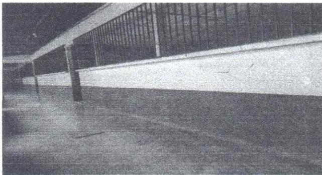
Foto 3: se observa las paredes de los modulos con la pintura ya escasa, es necesario aplicar resane y pintura.
