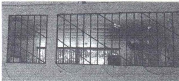
Foto 5: se observa los balcones de los módulos opacos por falta de pintura
