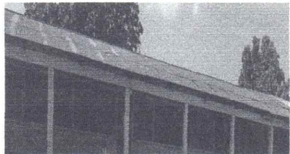
Foto 6: se observa el techo de los modulos en mal estado por lo cual es urgente sustituir las láminas.
