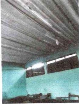
Foto 1: Se observa que el techo se encuentra en mal estado por lo que requiere ser sustituida
