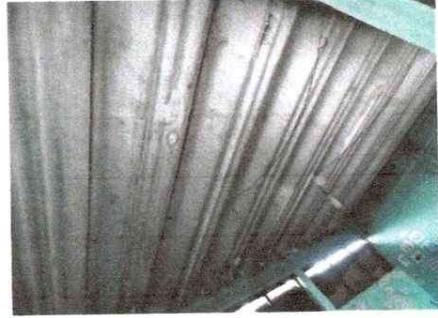
Foto 2: Se observa que el techo no cuenta con estructura por lo que requiere que se le coloque.
