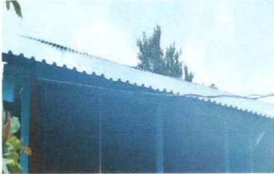
Foto 1: Se realizó el cambio de lámina del modulo.
