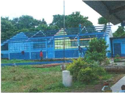
Foto 1: Se procede al desmontaje del techo
