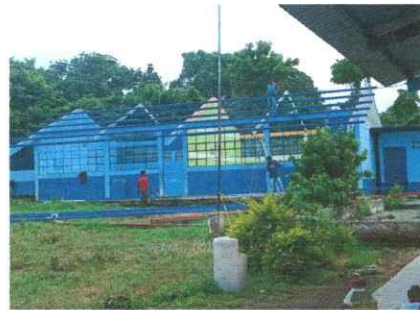
Foto 2: Se procede a colocar la estructura.
