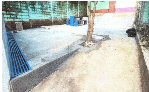
Foto 4: Se observan los trabajos finalizados en muro de protección, cuneta + rejilla y pavimento (empedrado fraguado)
