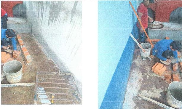
Foto 3: Se observa la reparación del polletón en proceso
