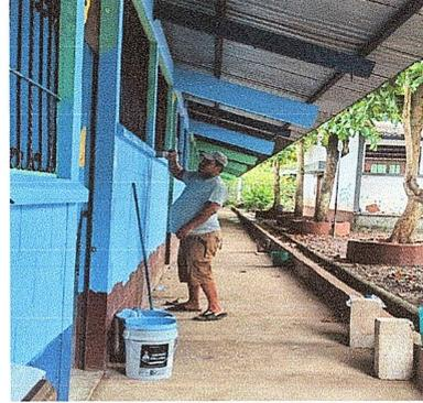
Foto 8: Se observa el proceso de aplicación de pintura en muros exteriores e interiores
