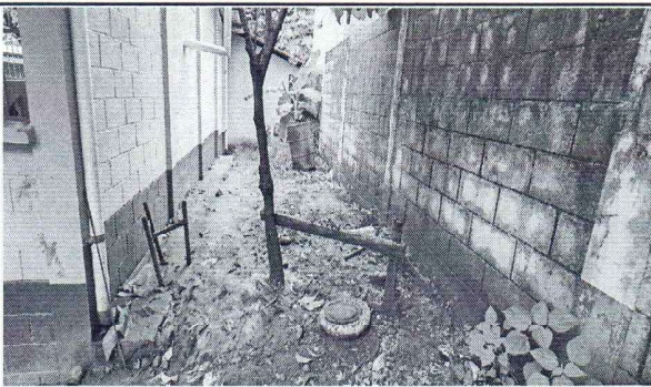
Foto 5: Se observa área con mucho lodo, es necesario suministrar pavimento de empedrado fraguado
