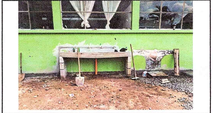
Foto 2: Instalación de estación de lavado para los niños.
