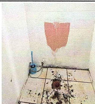
Foto 11: Instalación de inodoros.
