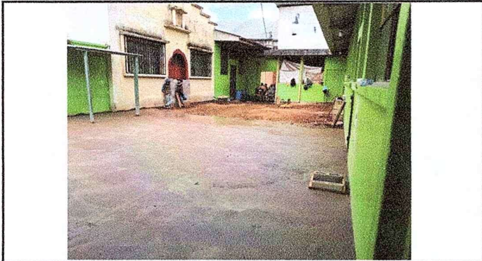
Foto 1: Fundición de la torta de cemento.
