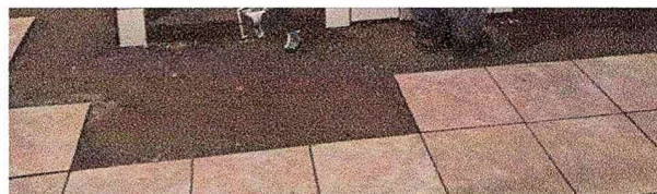
Foto 8: Instalación de piso cerámico en cocina.
