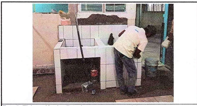
Foto 5: Elaboración de pileta de concreto con azulejos.
