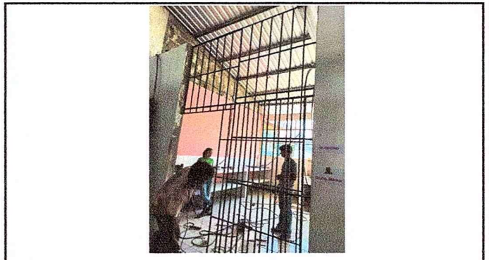
Foto 4: Instalación de baranda en la cocina.
