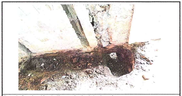
Foto 6: Sustitución de línea principal de drenaje.
