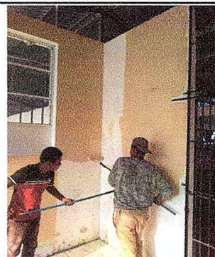
Foto 10: Aplicación de pintura en la cocina.
