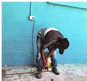
Foto 9: Mantenimiento de la puerta.
