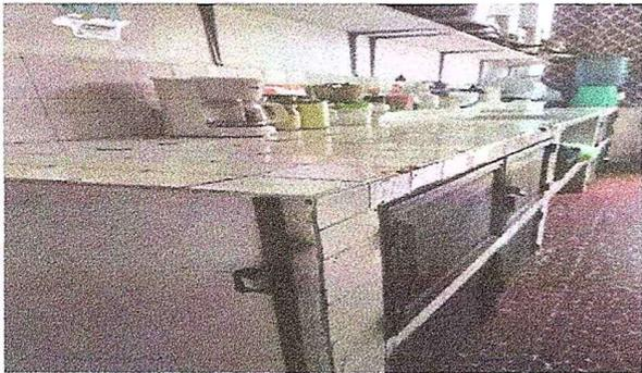
Foto 3: Se observa que el banco de trabajo se encuentra deteriorado, con los azulejos quebrados.
