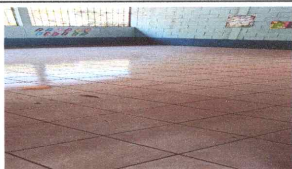
FOTO 6: Piso cerámico instalado en todas las aulas del módulo 2.
