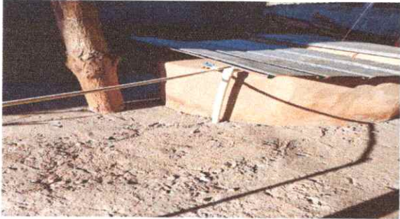
FOTO 7: Correcta instalación de tubería en el pozo.
