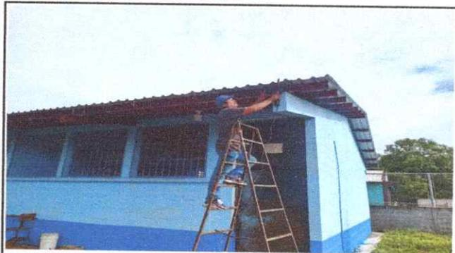
FOTO 4: Se realiza la instalación del canal plástico por uno de metal con sus respectivas caídas de agua.
