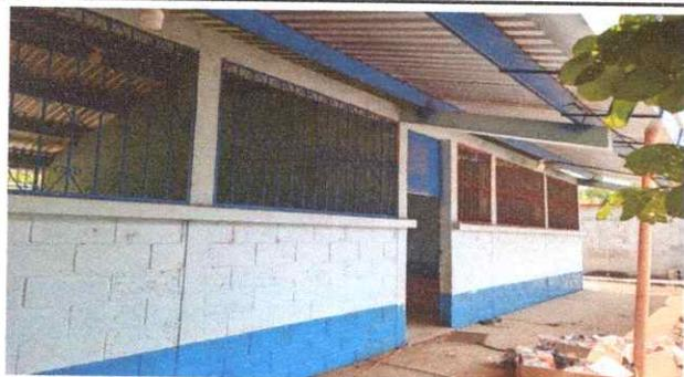
Foto 5: Se observa el mantenimiento de balcones, aplicación de pintura anticorrosiva, color azul.
