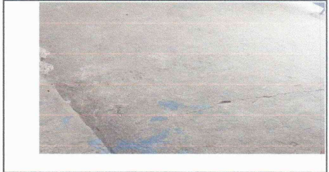
FOTO 6: Se observa que el piso esta en mal estado por lo que se necesita sustitucion por piso ceramico.
