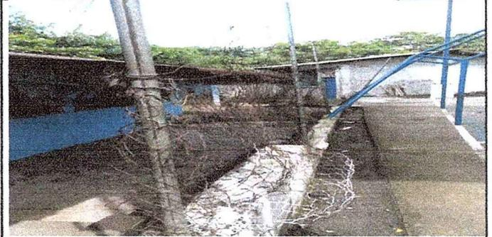
Foto 8: Se observa muro perimetral de malla en mal estado
