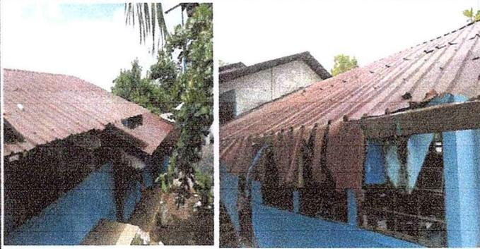
Foto1: Se observa techo de lamina en mal estado
