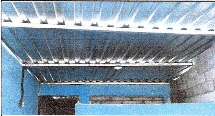
Foto 9: Se observa techo de lámina cambiado
