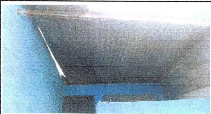
Foto 9: Se observa techo de lámina en mal estado
