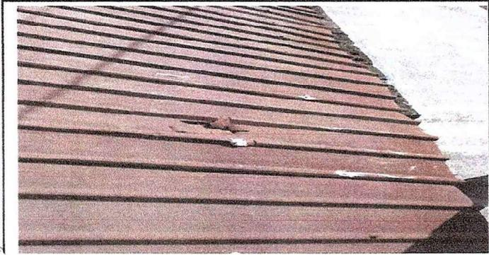
Foto 1: Se observa techo de lamina en mal estado en módulo 1
