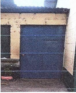
Foto 19: Sustitución de puerta de metal en módulo de aula finalizado.
