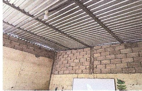
**Foto 2: Estructura de metal que da soporte a las láminas finalizada**
