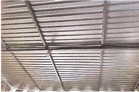
**Foto 1: Techo finalizado con lámina troquelada aluzinc calibre 26**
