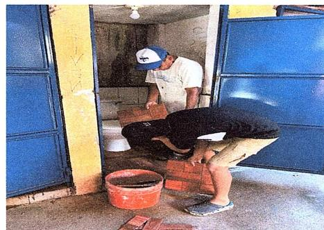
Foto 18: Proceso de colocación de piso antideslizante en el área del baño.
