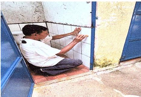
Foto 17: Proceso de colocación de azulejos.
