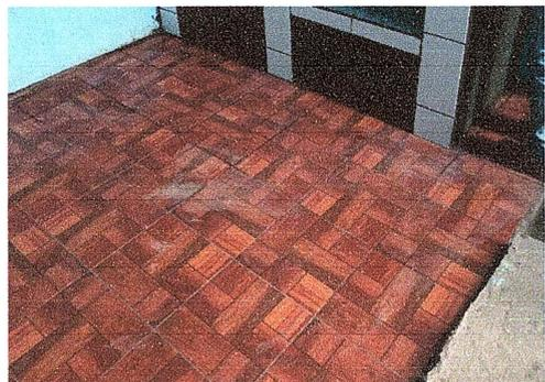
Foto 4: Sustitución completo del piso antideslizante, debido a que el piso de cemento estaba deteriorado
