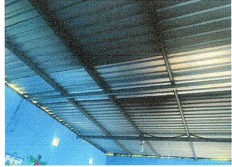
Foto 2: Se observa la colocación de la lamina troquelada por la que estaba dañada
