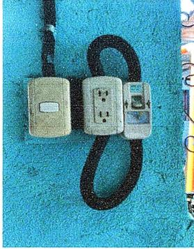
Foto 13: Se observa el sistema eléctrico colocado debidamente cubierto por una tubería para que se aisle por cuestión de seguridad
