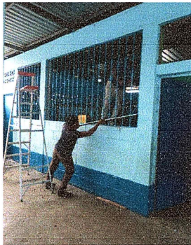
Foto 9: Se observa la instalación de los balcones.
