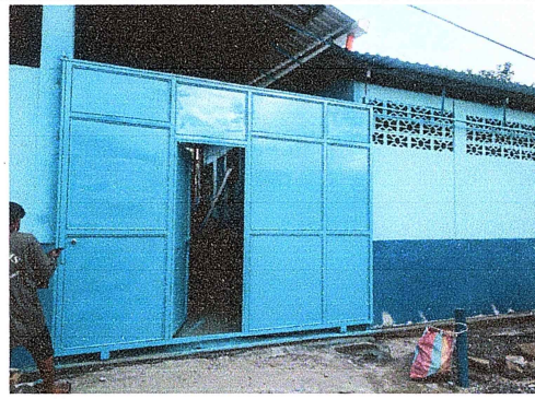
Foto 8: Se observa el cambio del porton en mal estado por este en un estilo corredizo
