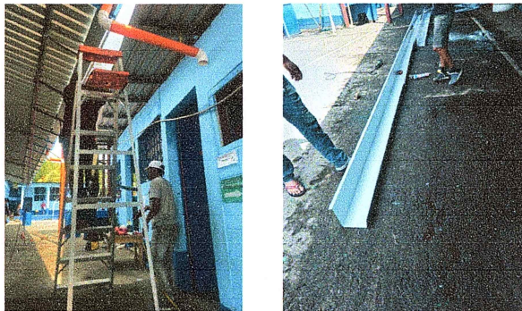
Foto 1: Se observa el proceso de colocación de canal para desfogar el agua pluvial(bajadas de agua) para que ya no inunde el acceso al establecimiento
