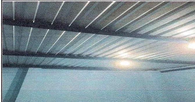
Foto 4: SE OBSERVA QUE SE HUBO SUSTITUCIÓN DE LÁMINA Y ESTRUCTURA METÁLICA.
