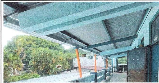
Foto 3: SE OBSERVA QUE EL CANAL SE SUSTITUYO, POR UNO MAS GRANDE
