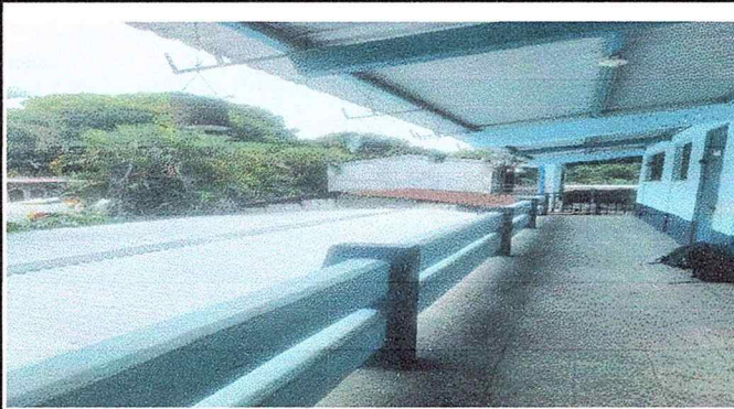
Foto 3: SE OBSERVA QUE YA QUITARON EL CANAL PARA CAMBIARLO POR UNO MAS GRANDE
