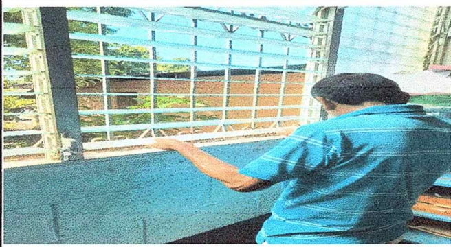
Foto1: SE OBSERVA QUE ESTAN INSTALANDO LAS VENTANAS EN LAS AULAS AFECTADAS POR LA LLUVIA
