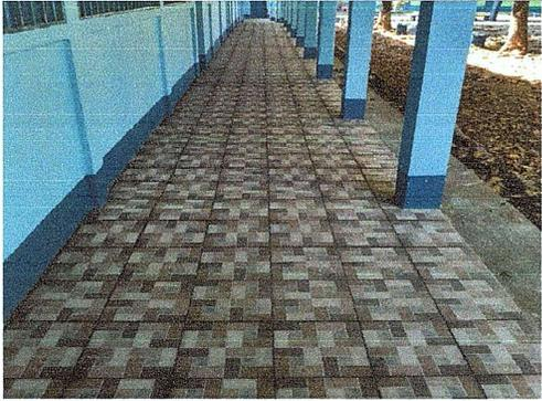
Foto 1: Se observa la finalización del piso cerámico
