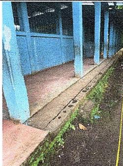
Foto 11: Se observa que la banqueta existente se encuentra undida y en mal estado
