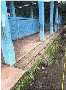
Foto 9: Se observa que al poner la cuneta de concreto se necesita poner una parrilla de metal para evitar accidentes
