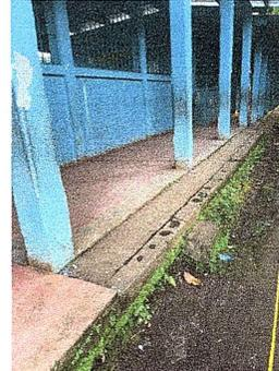
Foto 8: Se observa que el agua no cuenta con cuneta y tiende a derramarse en todo el area
