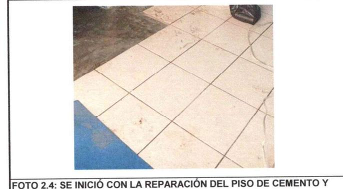
FOTO 2.4: SE INICIÓ CON LA REPARACIÓN DEL PISO DE CEMENTO Y COLOCACIÓN DE PISO CERÁMICO.
