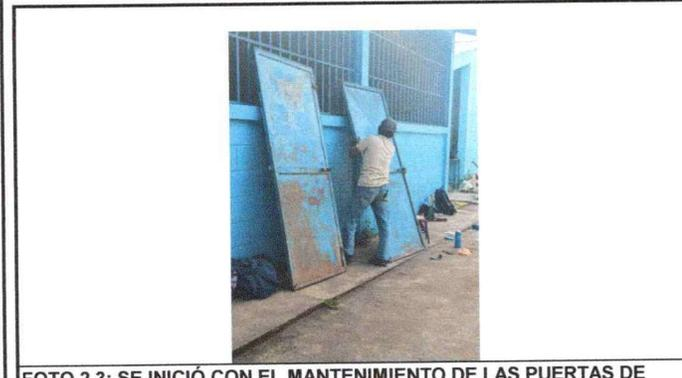
FOTO 2.3: SE INICIÓ CON EL MANTENIMIENTO DE LAS PUERTAS DE METAL.
