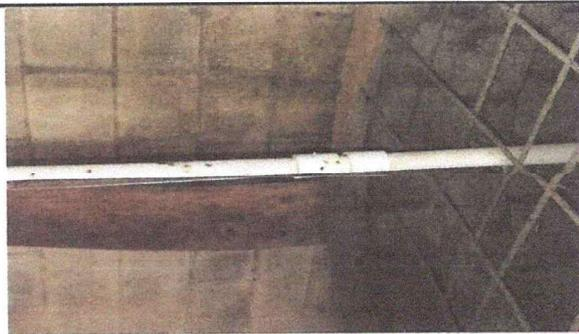
FOTO1.5: SE OBSERVA QUE NO FUNCIONA ADECUADAMENTE LÍNEA PRINCIPAL DE AGUA Y SE NECESITA UNA LLAVE DE PASO
