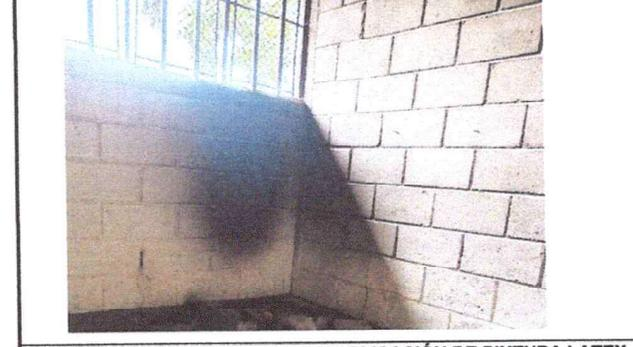
FOTO2.8: SE OBSERVA RESANE Y APLICACIÓN DE PINTURA LATEX ACRILICA
