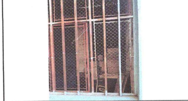
FOTO2.6: SE OBSERVA SUSTITUCION DE MALLA METALICA EN VENTANA
