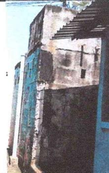
FOTO1.4: SE OBSERVA QUE SE NECESITA REPARACION DE MURO DE BLOCK DE CONCRETO
