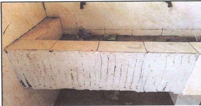
FOTO1.3: SE OBSERVA QUE SE NECESITA REPARACION DE ESTACION DE LAVAMANOS
