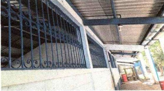
Foto 1: Se observa que se culmino con los trabajos en el mantenimiento de balcones de metal
