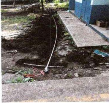
Foto 1: Se observa que se esta trabajando para el cambio de la tubería del drenaje debido a la erosión del terreno
