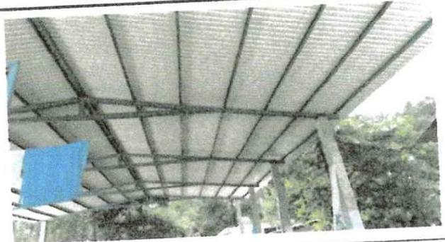
Foto 12: Se observa la necesidad de intalar canales con caídas de agua de 3"
