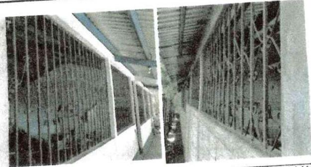
Foto 3: Se Observa la necesidad de darle mantenimiento a los balcones de metal debido a un alto nivel de corrosión, esto es en los dos módulos, cada módulo consta de tres aulas y una bodega, todas con balcones.
