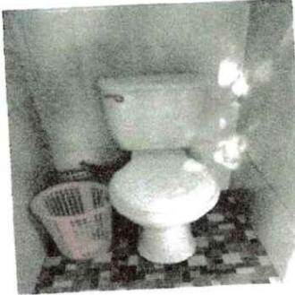
Foto 7: Se observa la necesidad de darle mantenimiento a los inodoros en relación a los equipos internos porque por el uso ya los equipos se arruinaron lo que ocasiona que el agua se vaya de manera constante.
