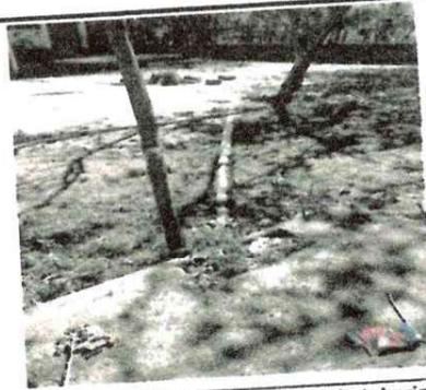
Foto 6: Se observa la necesidad de cambio de tubería de drenaje, esto debido a la erosión del terreno ha dejado al descubierto la tubería del drenaje lo que ocasionó que se quebrara.
