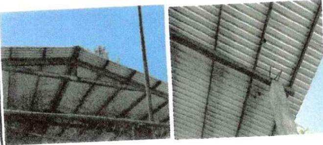
Foto 9: Se Observa la necesidad de darle mantenimiento a la estructura de metal de la cancha deportiva, porque desde su construcción no se ha hecho un mantenimiento adecuado y los signos de corrosión son evidentes.
