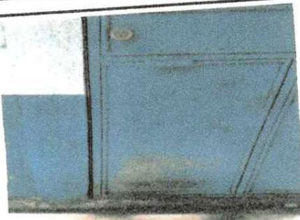
Foto 4: Se Observa la Necesidad de darle mantenimiento a las puertas de metal debido que la corrosión en la parte baja es evidente.
