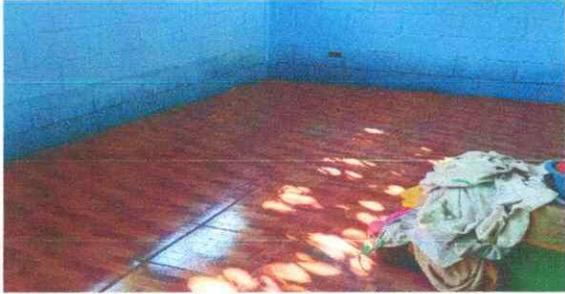
Foto 1: Se observa la finalización de colocación de piso cerámico
