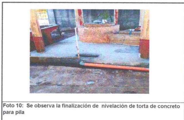
Foto 10: Se observa la finalización de nivelación de torta de concreto para pila
