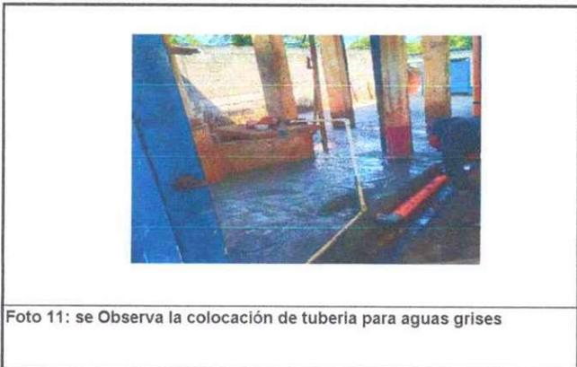
Foto 11: se Observa la colocación de tubería para aguas grises
