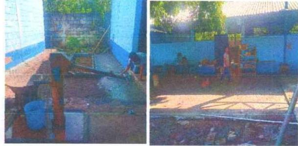
Foto 2: se observa que se está realizando la colocación de la torta de cemento
