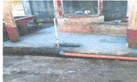
Foto 10: Se observa que se está realizando la conformación y nivelación de la torta de cemento
