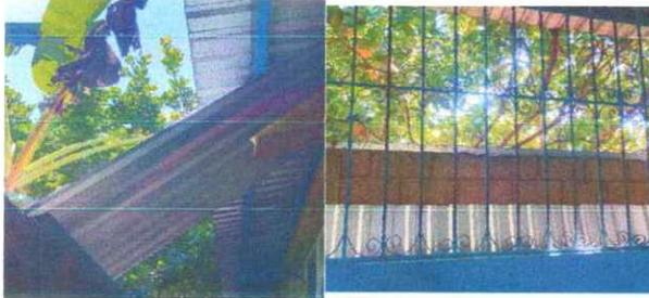
Foto 3: se observa que se está realizando el cambio de de la estructura de madera por metal y lamina troquelada.
