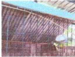
Foto 3: Se observa la necesidad del cambio de la estructura de madera por metal y lamina troquelada debido al deterioro por la lluvia
